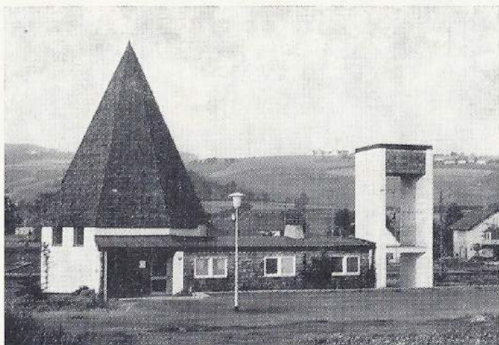
Evang. Kirche mit Pfarrsaal, Mesnerwohnung und Glockenturm
