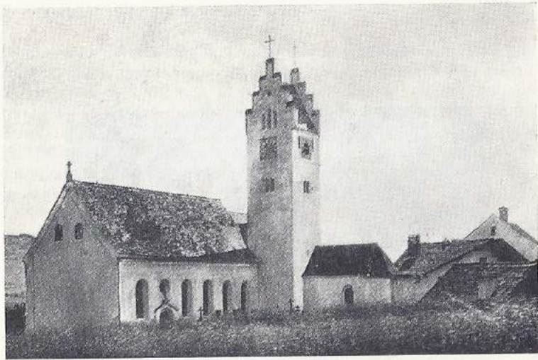
Die alte Pfarrkirche wurde 1936 abgerissen
