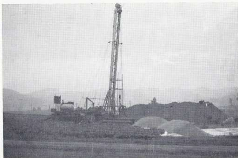
Bohrgerät bei der Bohrung des Tiefbrunnens 2 (Spülbohrung)
