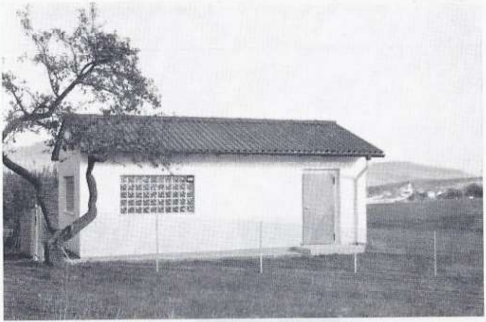
Druckbehälterpumpwerk in Steckenhof
