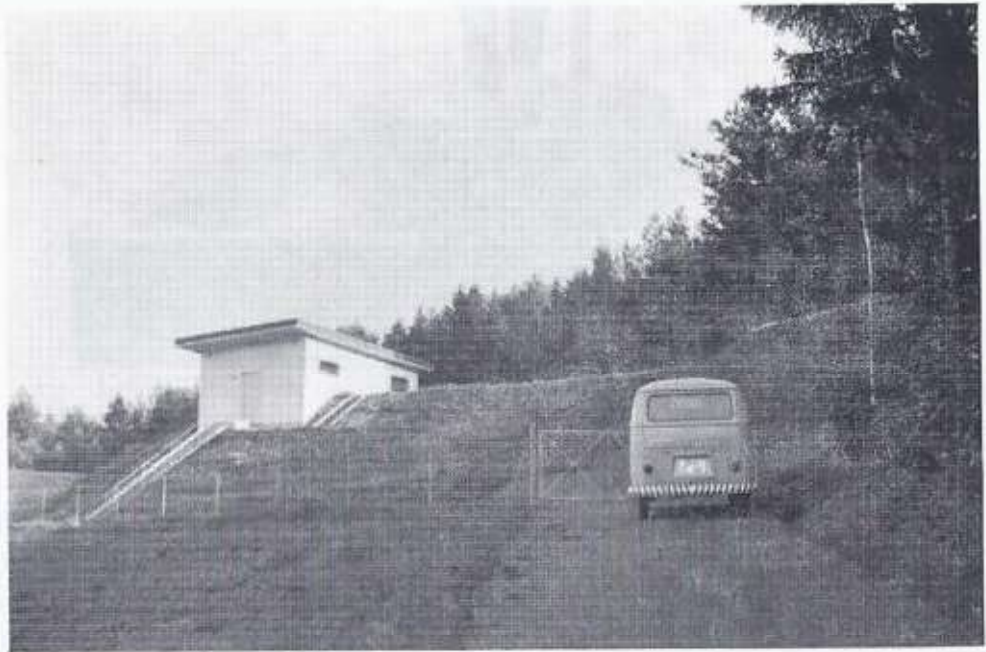
Hochbehälter 500 nach Fertigstellung
