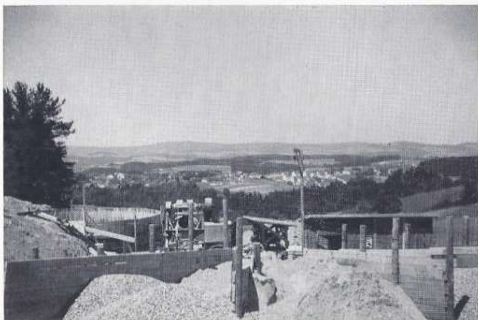
Hochbehälter 500 in Mitterfels im Bau
