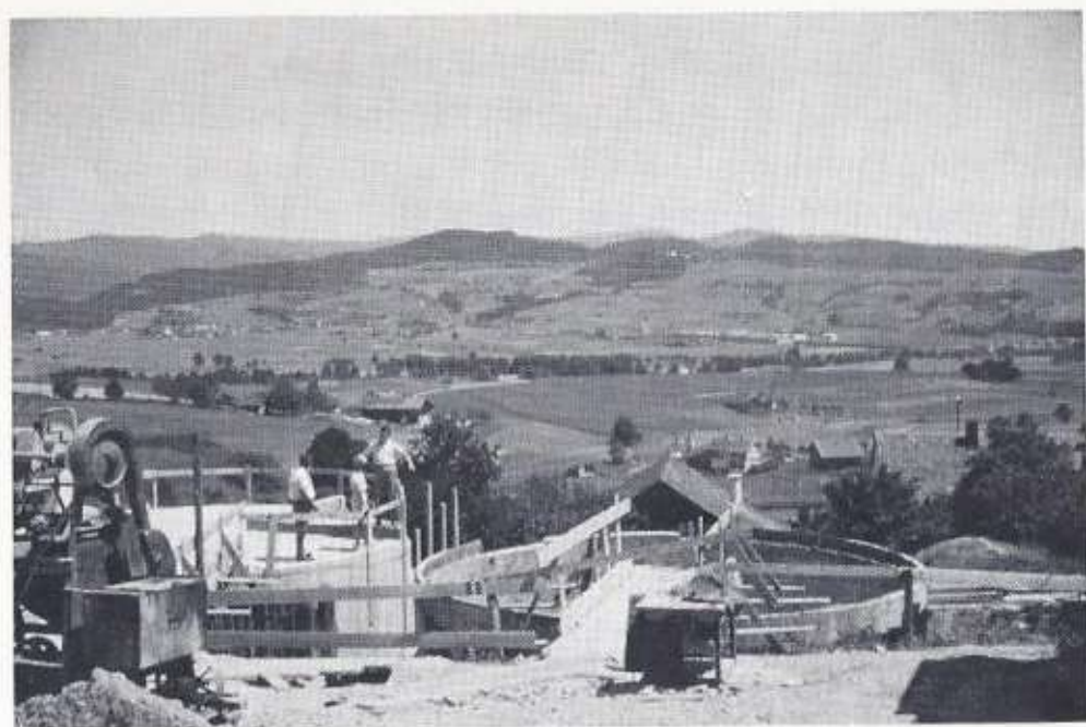
Hochbehälter 350 mit Überhebepumpwerk in Hunderdorf im Bau
