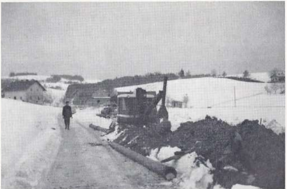
Verlegung der Hauptverbindungsleitung Hunderdorf-Mitterfels (Winter 1962 - 63)
