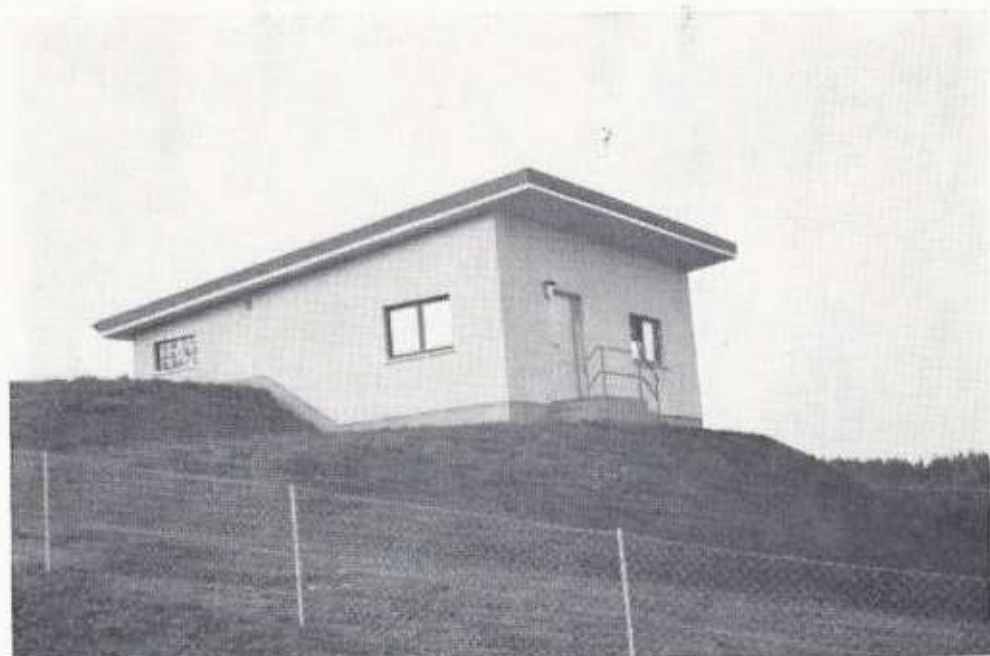
Hochbehälter 350 nach Fertigstellung
