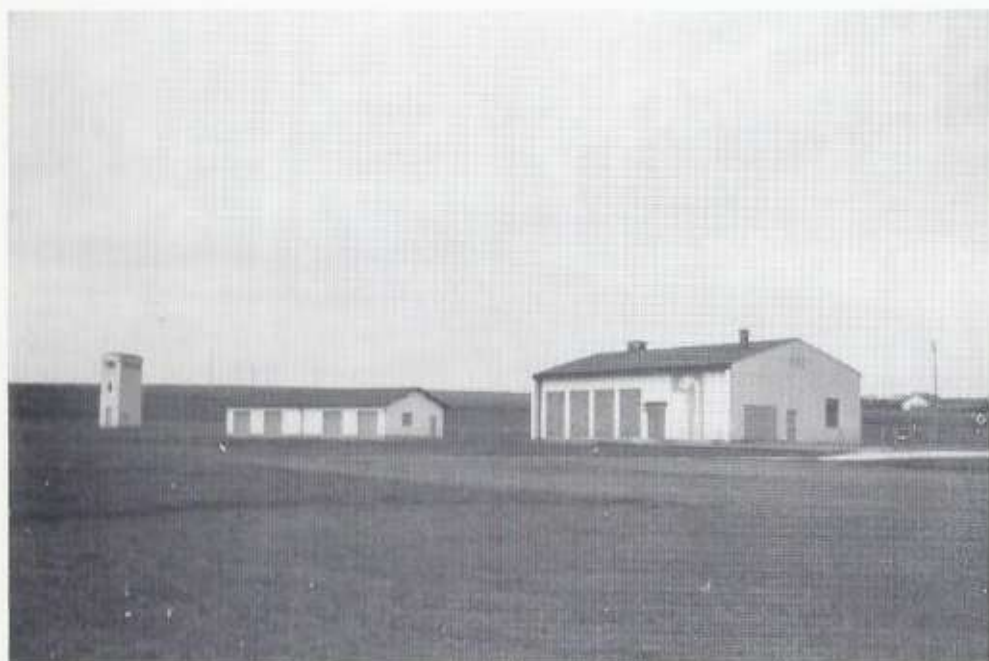
Hauptpumpwerk- Aufbereitungsanlage, Lagerhalle u. Trafostation in Hunderdorf
